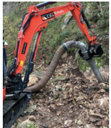
◀ Concassage-criblage-tri des rhizomes en berges - © N. Balverde
