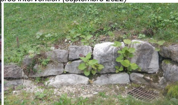
Après intervention (septembre 2022)
