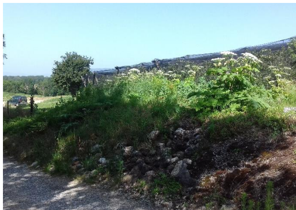
Jun 2019 – Avant intervention
