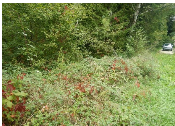
Après intervention (septembre 2022)
