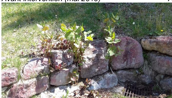
Avant intervention (mai 2019)
