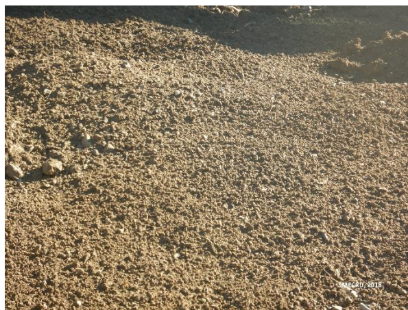
Matériaux traités avant bâchage
