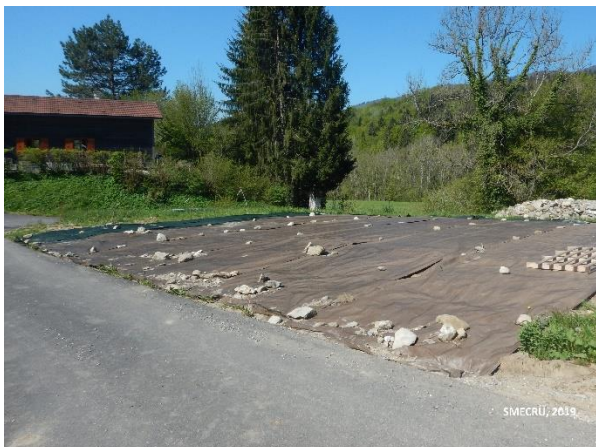
Surface traitée et bâchée
