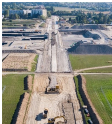
Mail central en chantier
