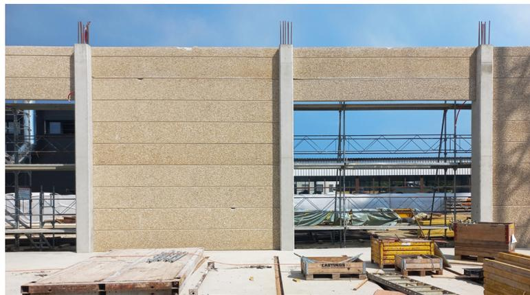
Parois en panneaux béton préfabriqués réemployés
