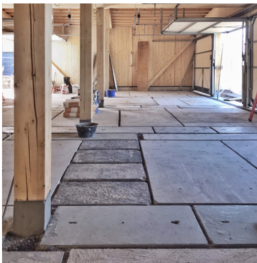
Sol du garage en dalles de réemploi
