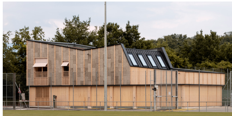
Vue extérieure du bâtiment
