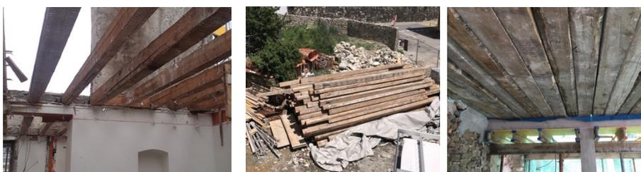
Figure 9 : Réemploi ex situ, externe et déphasé, photos du projet d'habitat collectif Denens (photos Coop. d'archi C/O)
