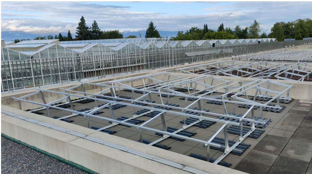
Figure 3 : Montage des structures PV
