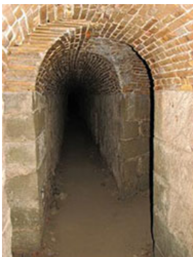
Figure 15 : Galerie de contre-mine, Genève, photo : IMAHGE
