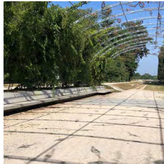
Couvert végétal proche de l'Aire
