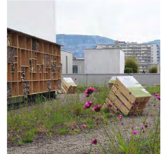
Toiture végétalisée à Onex © VIMADE
