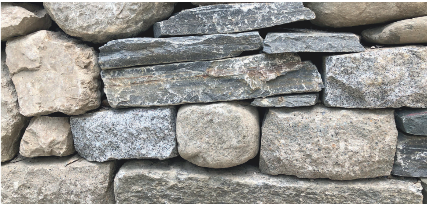
Lullier - aspect hétérogène d'un mur constitué de diverses formes de pierres et de béton recyclé.
