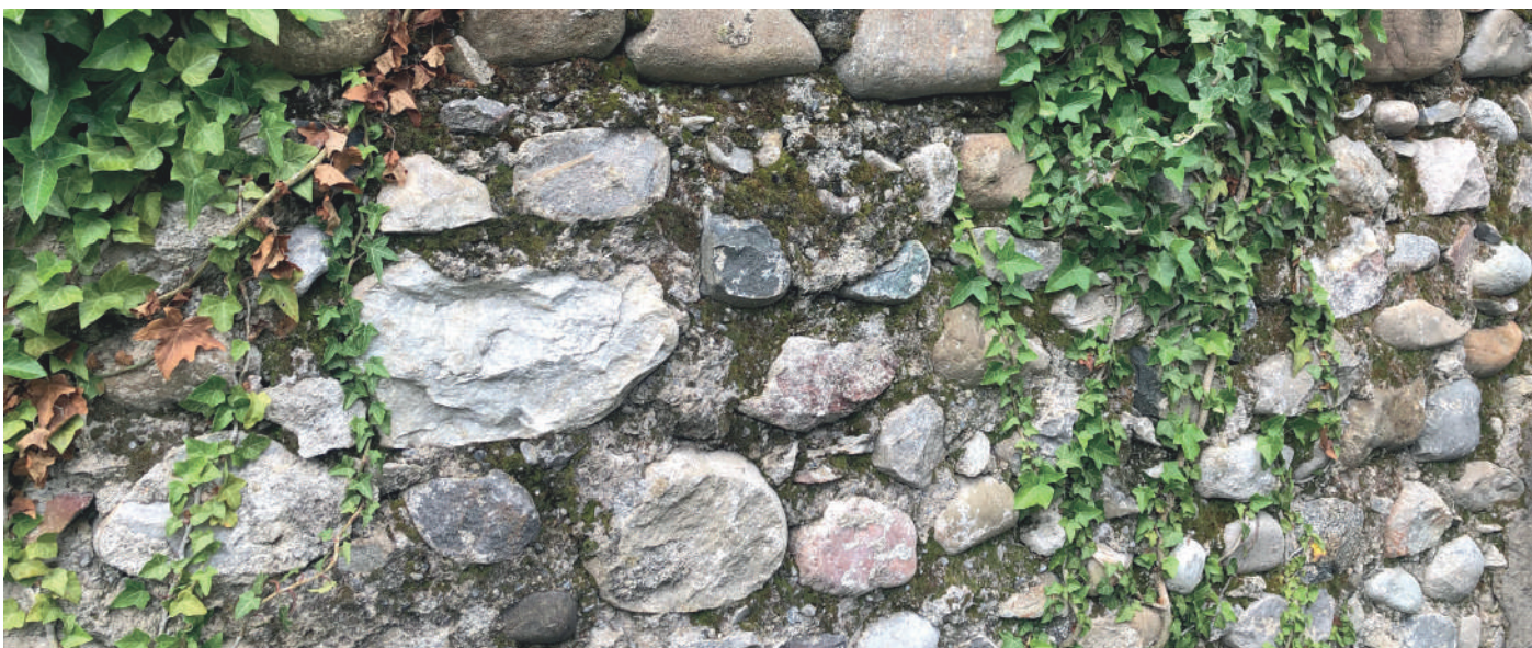
Bernex - Mur de limite en «boulets» assemblés au mortier. L'enduit de protection a été érodé par les intempéries laissant apparaître «l'ossature» du mur qui parle de la diversité géologique des gisements alluvionnaires.
