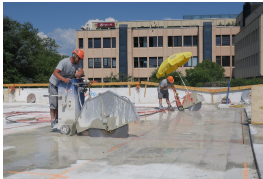
Figure 9 : Photo de la découpe de la dalle à la scie routière, projet Rebuilt © KÜPFER Célia_EPFL-Baumettes
