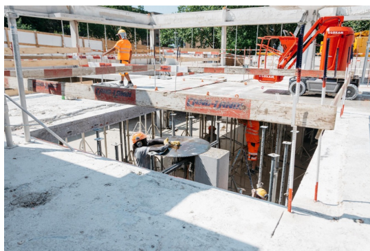
Figure 2 : Photo de la découpe d'un poteau à la scie, projet Rebuilt © KÜPFER Célia_EPFL-Baumettes
