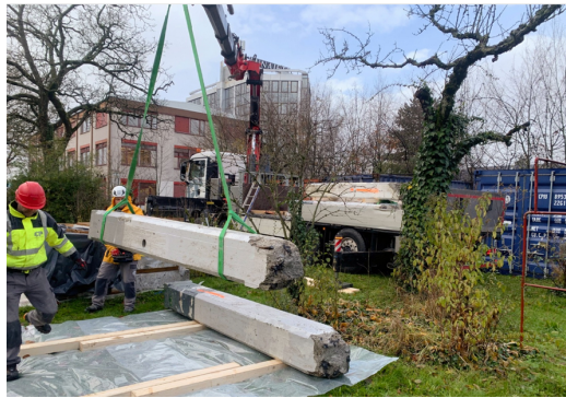
Fig. 6 : Photo du levage d'un poteau, projet C © Commune de Meyrin, ATBA, Atelier d'Ici, ZS, Sotrag, Construction Perret, Labotech
