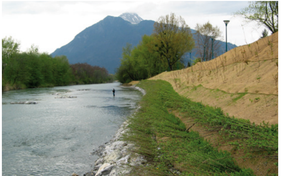
Restauration de berge à l'aide de techniques de génie végétal.
