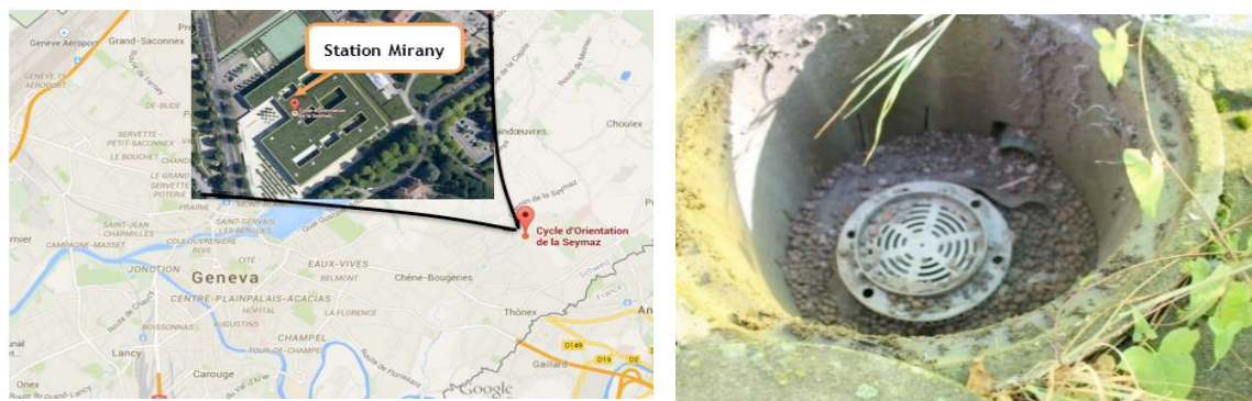
Figure 2: Localisation du toit vert et de la station pluie-débit Mirany (à gauche). Drain de la toiture avec vortex (à droite)
