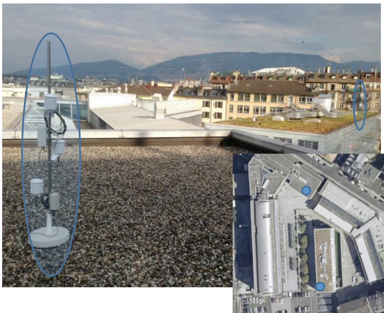
Figure 17 : Stations de mesure des températures de l'air en été vues depuis la toiture gravier et repérage des emplacements sur plan. Source du plan : sitg.ch
