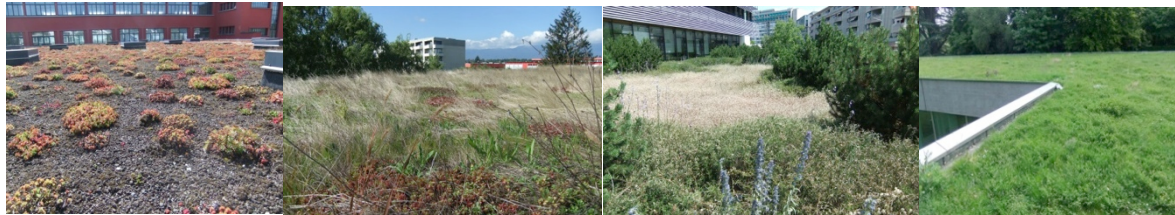
Figure 1. Toitures végétalisées n° 11, 42, 62 et 61.
