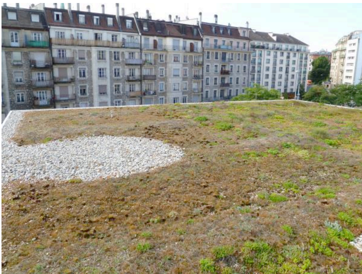
Figure 4 : Toiture de la HEAD - photographie montrant les zones TG et TV.
