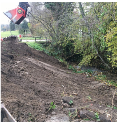
◀ Concassage-criblage-tri des rhizomes en berges - © N. Balverde
