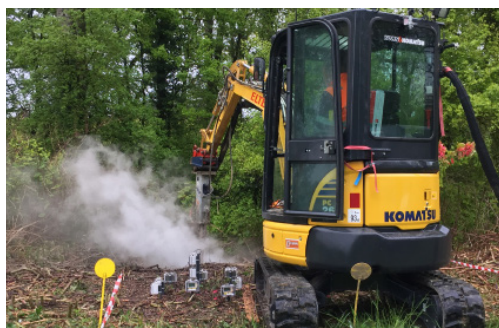
◀ Traitement en cours sur une surface équipée de sondes de température - © L. Huber
