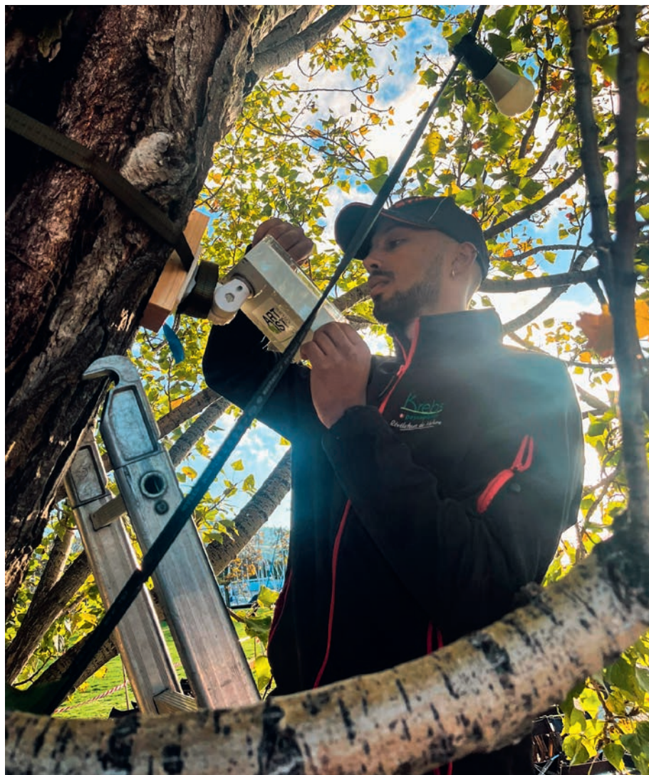
Opérateur en cours d'installation du boîtier.
