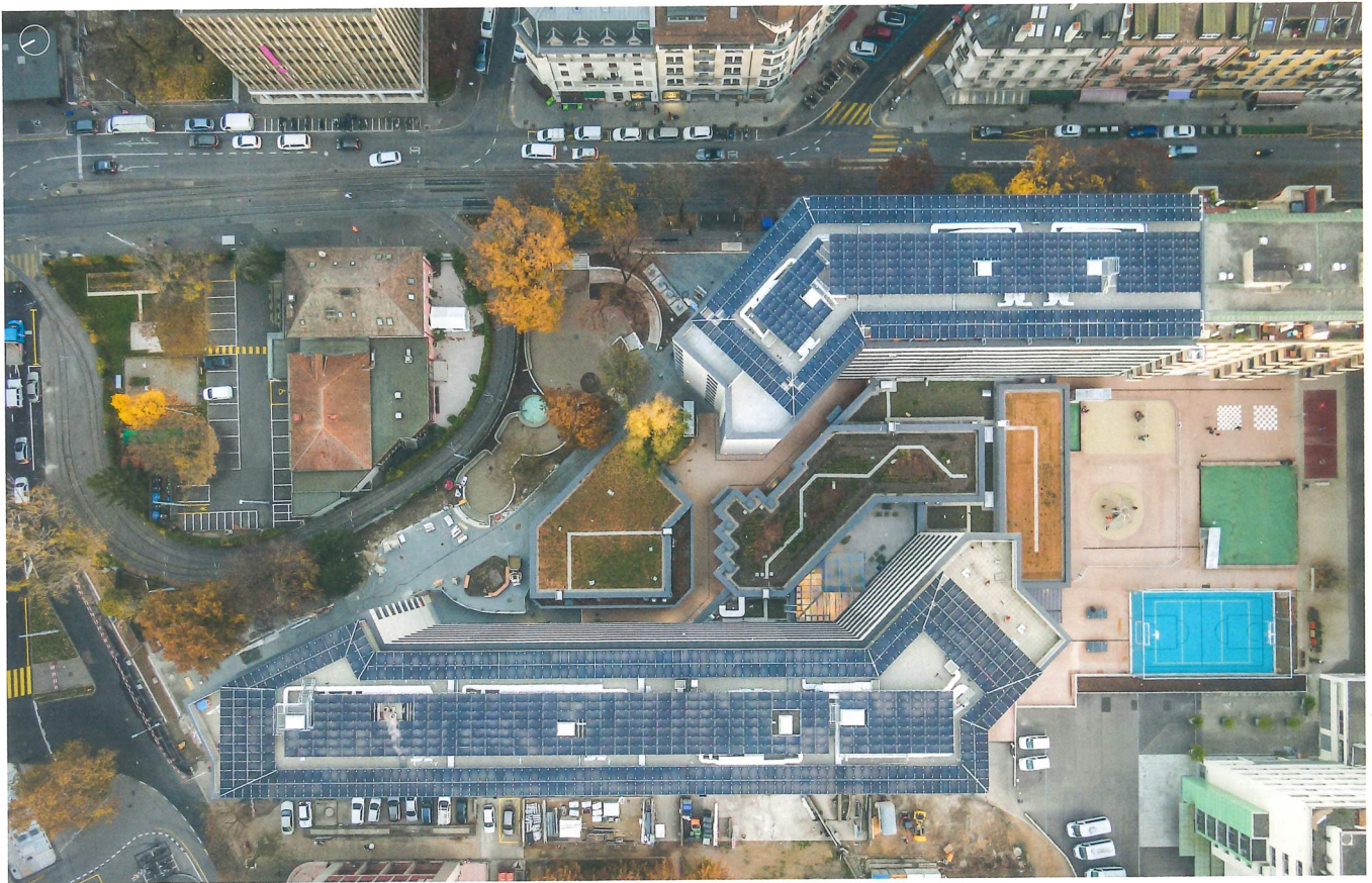
5 Erneuerbare Energien: Auf den Dächern der beiden Hauptgebäude und den Pergolen wurden Solarkollektoren und Photovoltaikpaneelen angebracht. Énergies renouvelables: Sur les toits des deux bâtiments principaux et des pergolas, des collecteurs solaires et des panneaux photovoltaïques ont été installés. Energie rinnovabili: sui tetti dei due edifici principali e sulle pergole, sono stati installati collettori solari e pannelli fotovoltaici.
