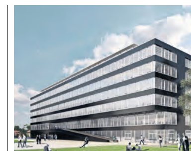
L'immeuble, édifié autour d'une colonne vertébrale centrale en dur, se caractérise par un volume compact et simple.
